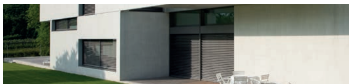
PORTONES ELÉCTRICOS EN COCHERA
